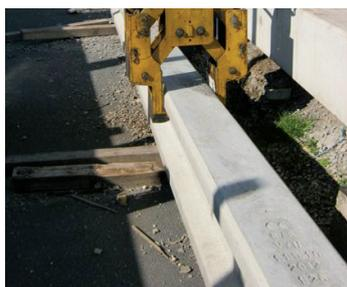
**Le trainage des supports sur le sol est interdit**
