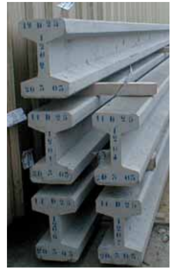
Stockage sur trois niveaux maxima, prévoir une stabilisation par groupe de deux ou trois piles.
